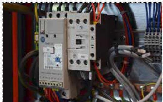
**Startér elektromotoru s plynulým rozběhem** bez rázů („soft-starter“) umožňuje snížení zátěže, krouticího momentu v pohonného ústrojí a skokového nárůstu spotřeby elektrického proudu elektromotoru během spouštění.
